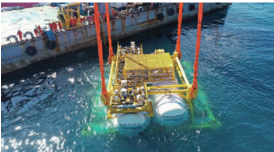
중국 하이난섬 연안에 배치한 하이랜더의 해저 데이터모듈. 차가운 해수를 자연 냉각수로 활용해 냉각 효율을 극대화하고 전력 소모를 줄이는 차세대 친환경 모델이다.
