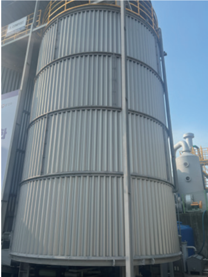
가축분뇨와 커피박을 섞어 고체연료를 생산하는 고속 발효 건조장치. 유용 미생물을 활용한 발효 기술로 환경문제 해결과 농가 실익이라는 두 마리 토끼를 잡았다.
