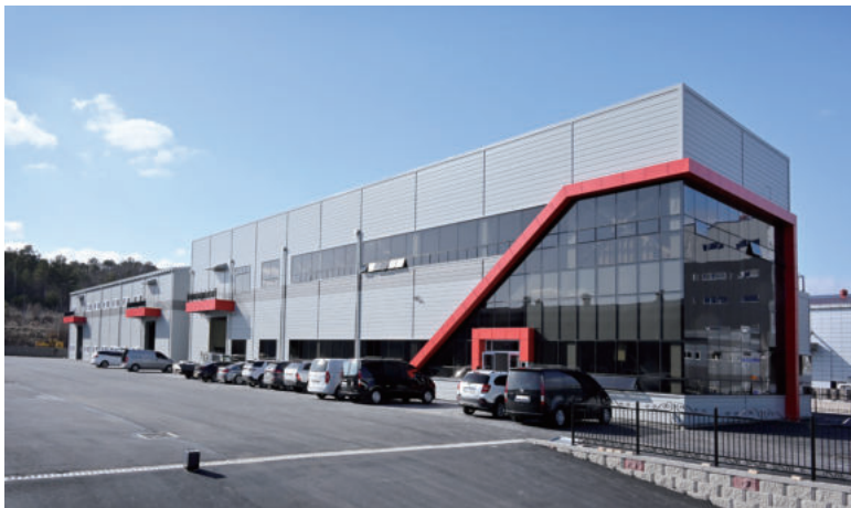
2023년 1월 완공된 ㈜피티지의 e플랫폼 제작 신축 공장 전경.
