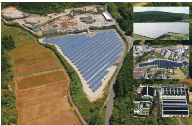
일본에 설치된 알루미늄 거치대 및 태양광 모듈 프레임이 포함된 발전소 전경
